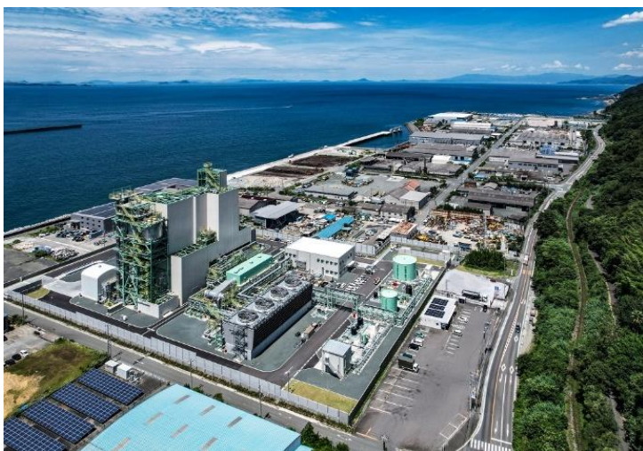
○大洲バイオマス発電所
